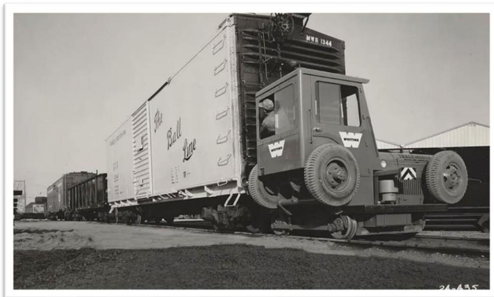
*Ilustración 8 Trackmobile Whiting 5TM en operación*
