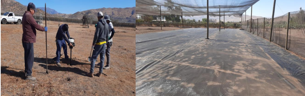
Despeje e instalación de sombreadero y malla antimaleza
