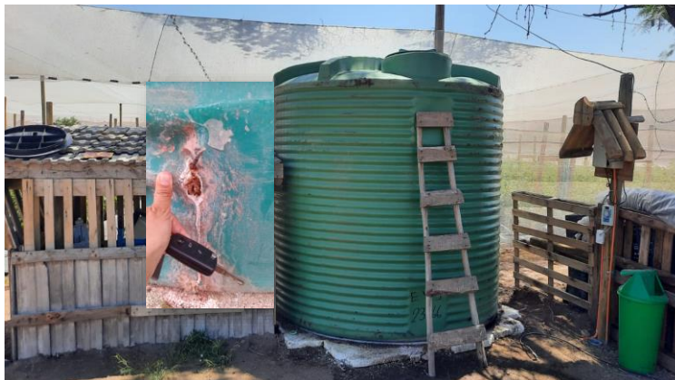
Cambio del estanque de acumulación de agua, por daños en el original.
