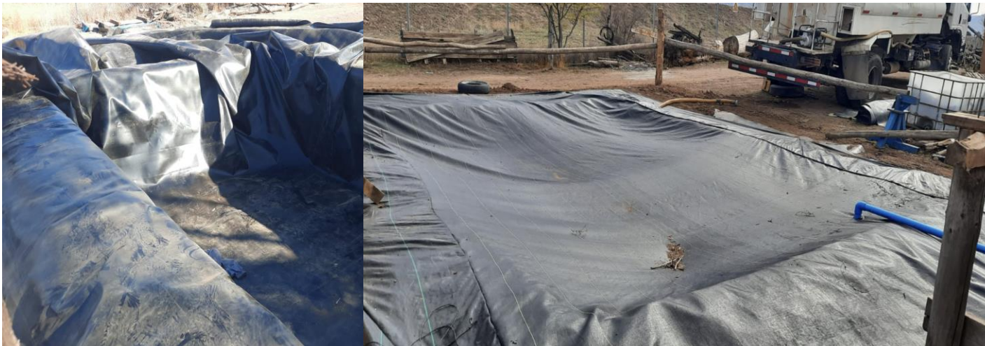
Impermeabilización de piscina de acumulación
