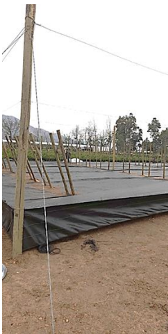
Instalación de sombreadero y malla antimaleza.
