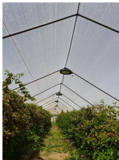
En Santa Filomena se instalaron focos que funcionan con energía proporcionada por un panel solar.
