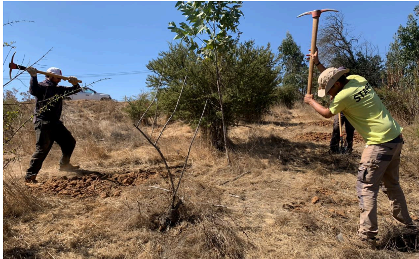
Imagen 4: Elaboración de zanjas de infiltración de aguas lluvias en el Parque la Reserva de Peñablanca. Villa Alemana, Región de Valparaíso. Año 2024.
